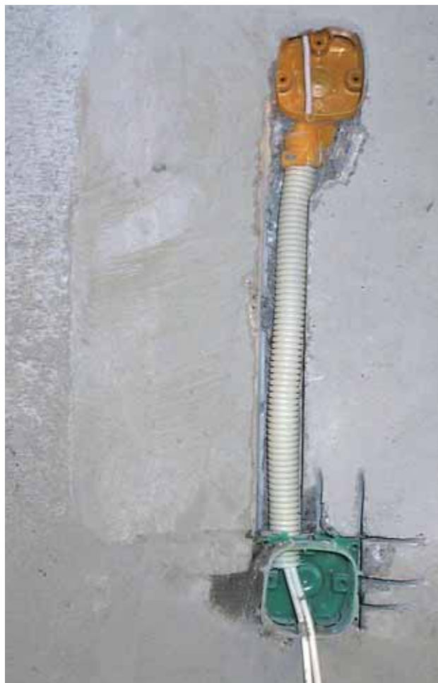
Figur 41. Udbedring af fejlplaceret dåse.
