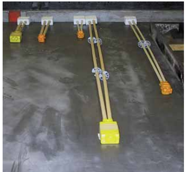
Figur 22. Støbebord til et letklinkerbetonelement. I formsiden er anbragt FUGA indstøbningsdåser og dåser til flerpolede stikkontakter. De længste rør er forsynet med afstandsholdere, (»citron-skiver«), der sikrer fuld omstøbning af rørene.
