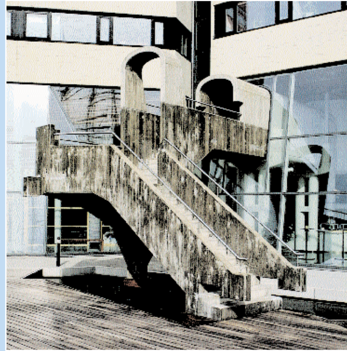
FIG. 1 HVIDE BELÆGNINGER PÅ BETONOVERFLADER ER ET IRRITERENDE PROBLEM, BÅDE FOR BYGHERREN, FOR BYGNINGENS DESIGNERE OG FOR HÅNDVÆRKEREN, DER HAR OPFØRT BYGVÆRKET. KILDE: "CEMENTA" BROCHUREN "KALKUTFÅLLNINGER PÅ BETONGYTOR", 1999.
