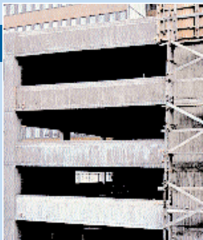
FIG. 2 AF PARKERINGSHUSETS FIRE ETAGER BLEV DEN NEDERSTE STØBT OM VINTEREN, DEN ØVERSTE OM FØRSOMMEREN OG DE TO MIDTERSTE SENT PÅ VINTEREN OG OM FORÅRET. RESULTATET ILLUSTRERER, AT RISIKOEN FOR KALKUDBLOMSTRING ER STØRST PÅ DEN KOLDE OG REGNFULDE TID AF ÅRET.
